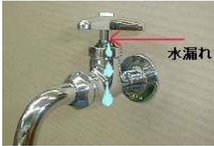
バルブの下からの水漏れの場合は、まず下記図のようにナットを締め付けします。
