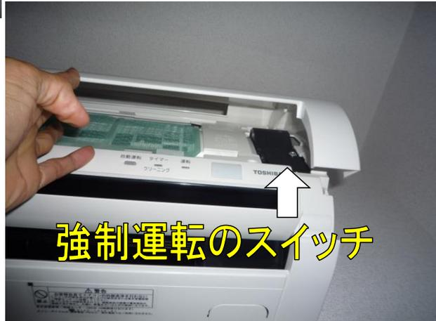
リモコンがどうしても使えない場合、このスイッチを押していただくと、リモコンで最後に設定した内容でON-OFFできます。(機種によっては運転設定も出来るものもあります)
